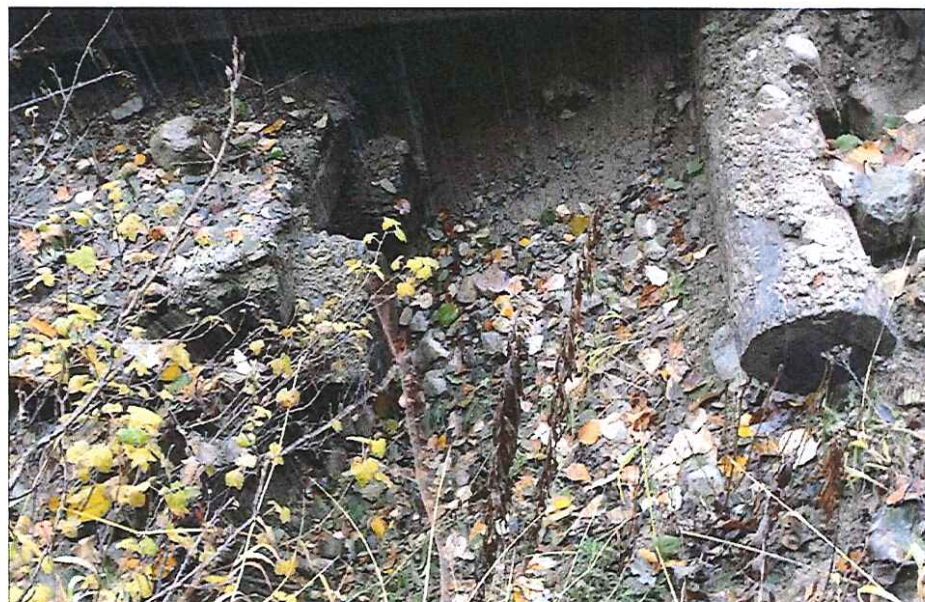
CK2308 Right upstream fill
